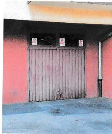
Slika 7: Ulaz u garažu
