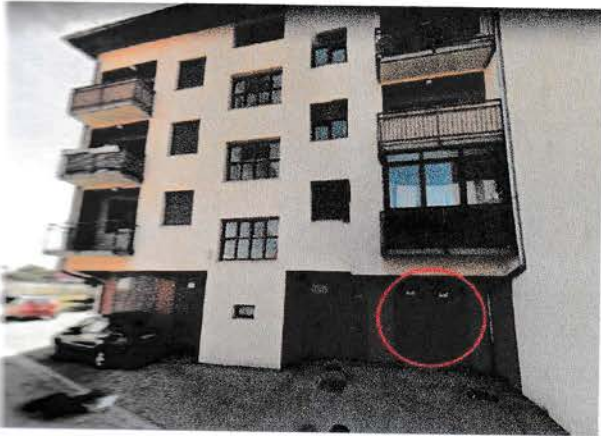
Slika 6: Pogled na sjeverno pročelje zgrade
